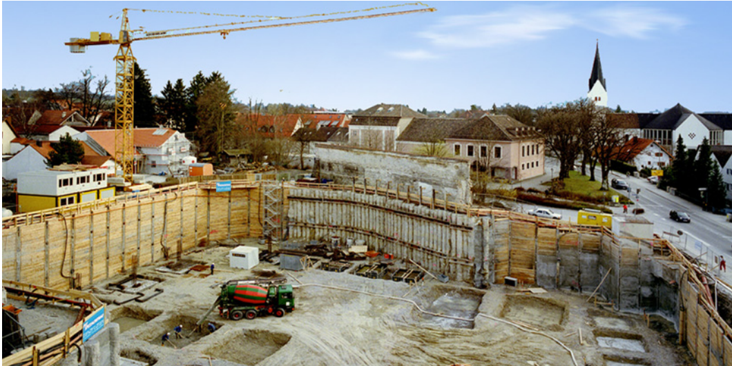
Wohn- und Geschäftshaus in Weilheim
